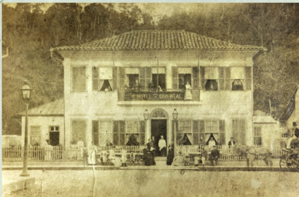
Fachada do Hotel Oriental, que ficava localizado na Rua Sete de Abril. Acervo Museu Imperial.
