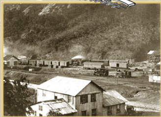
Estação ferroviária do Alto da Serra, vendo-se as oficinas de reparo de trens, 1890. Acervo Museu Imperial.
