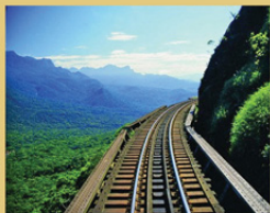
Trecho da ferrovia Paranaguá-Curitiba (PR), onde trafega o Trem da Serra do Mar. Acervo Serra Verde Express.
