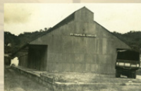
Estação de cargas de Petrópolis, no Morin, prestes a ser demolida, já sem trilhos. Acervo Museu Imperial.
