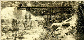
Viaduto do Itamarati, vendo-se o túnel no canto superior esquerdo, 1892. Acervo Museu Imperial.
