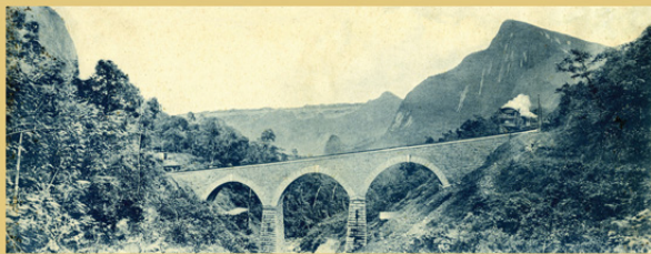
Vista da Linha Grão Pará na serra de Petrópolis, vendo-se o trem passando pelo viaduto da Grotta Funda. Acervo Museu Imperial.
