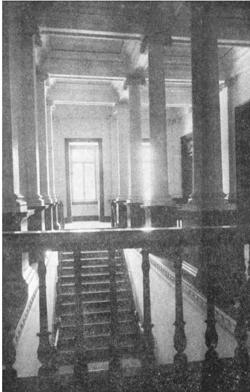
Saguão do sobrado e trecho da escada
