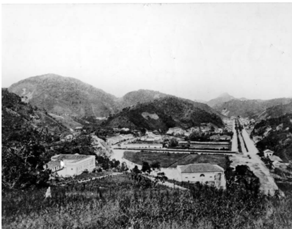
Fotografia tirada do alto da rua Silva Jardim em Petrópolis, antiga rua dos Mineiros, vendo-se à esquerda a residência do ministro Andrés Lamas e à direita, em reta, a atual avenida 15 de Novembro. Época provável. 1860 (Museu Imperial).
